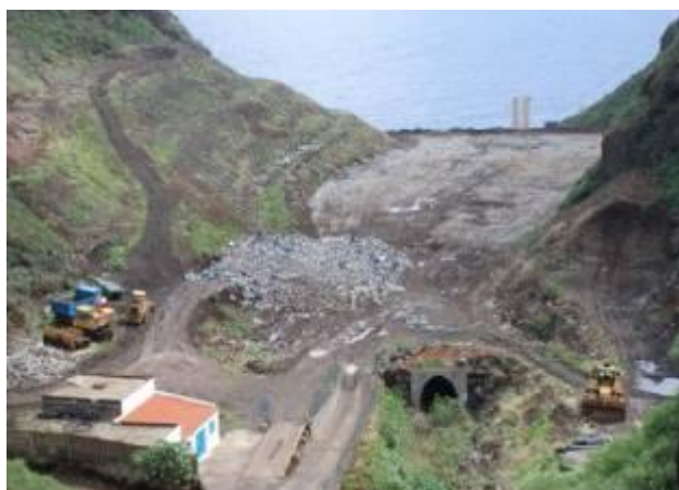
Vaso de residuos sólidos en explotación
