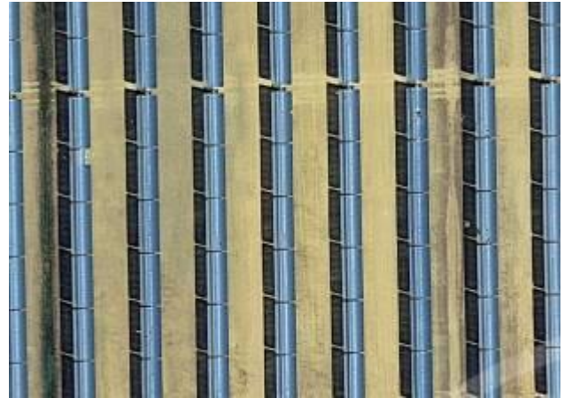
Detalle de elementos parabólicos en central termosolar
