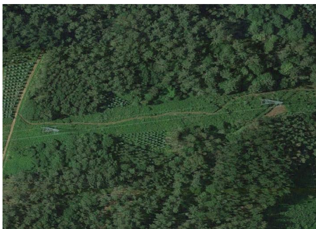
Cortafuegos y línea eléctrica coincidentes
