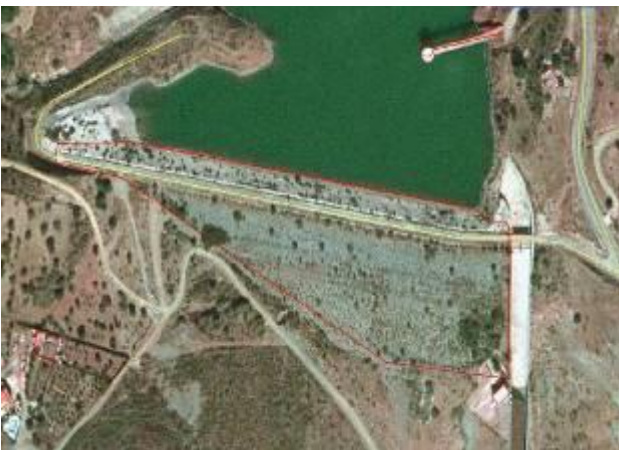
Presa de materiales sueltos (tierra)
