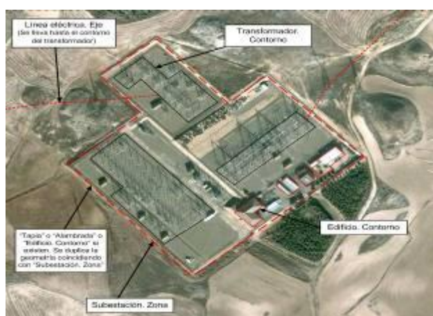
Captura de una subestación eléctrica
