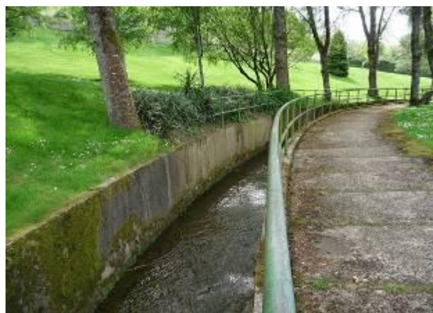
Río canalizado de ancho < 5m
