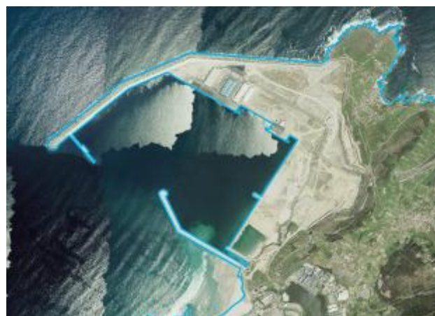
Línea de costa artificial en un puerto
