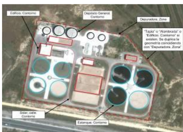
Estación depuradora de aguas residuales (EDAR)
