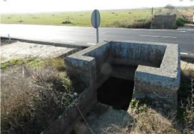
Tramo subterráneo que cruza una vía
