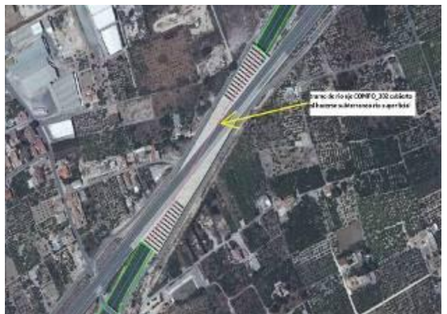
Tramo de río cubierto al hacerse subterráneo
