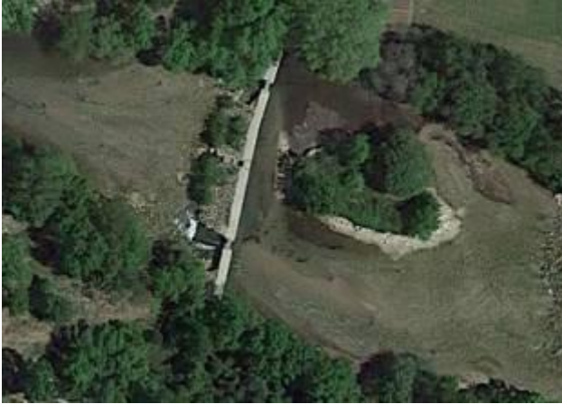
Represa de hormigón en un cauce natural
