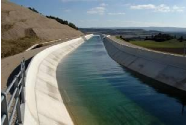
Canal en superficie
